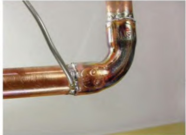
8 - Éloignez la flamme, puis appliquez aussitôt la brasure autour des deux joints.
