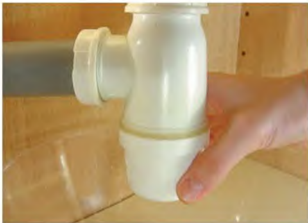
2 - Dévissez le culot du siphon, laissez l'eau s'écouler.
