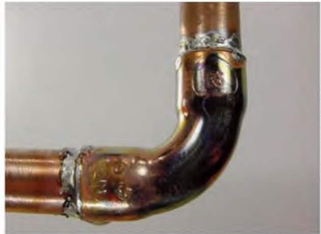
9 - Si le métal est assez chaud la brasure est aspirée par capillarité dans le joint. Sinon chauffez encore.
