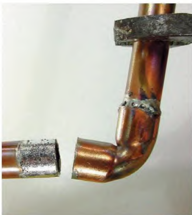
2 - Lorsque la brasure fond, démontez l'assemblage avec une pince multiprise.
