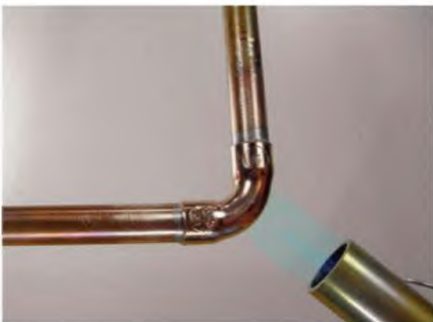
7 - Chauffez le raccord avec une petite flamme jusqu'à ce qu'il rosisse.
