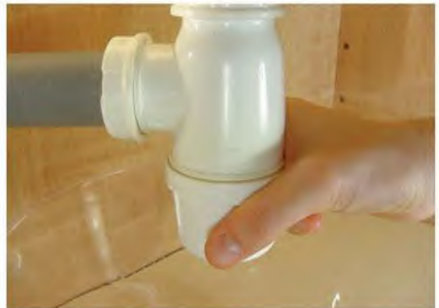
6 - Remontez le culot du siphon.
