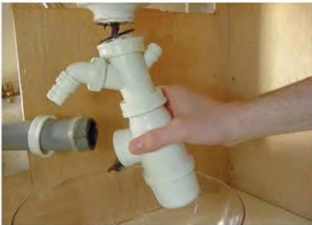
3 - Retirez le siphon.
