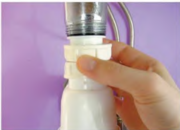
3 - Dévissez l'écrou supérieur du siphon.
