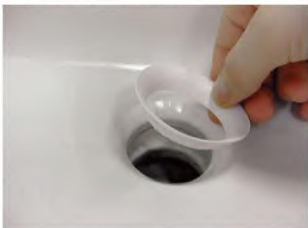
8 - Placez le nouveau joint ou éventuellement un cordon de mastic sanitaire.
