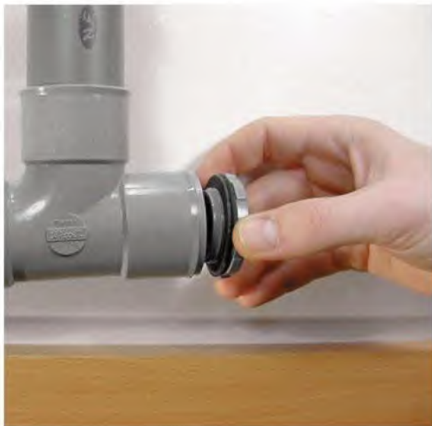
1 - Dévissez le bouchon du tampon de visite. Attention à l'écoulement d'eau possible.
