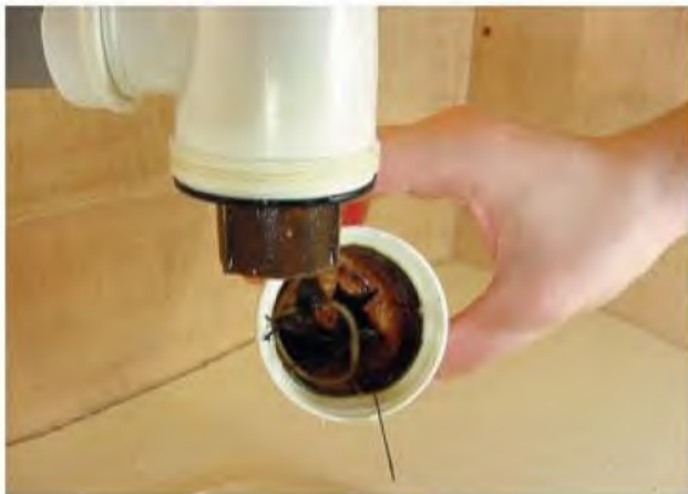
3 - Nettoyez le culot et l'intérieur du siphon.
