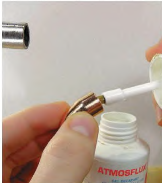
4 - Utilisez un coude neuf. Enduisez de flux les parties internes du coude et externes du tuyau.
