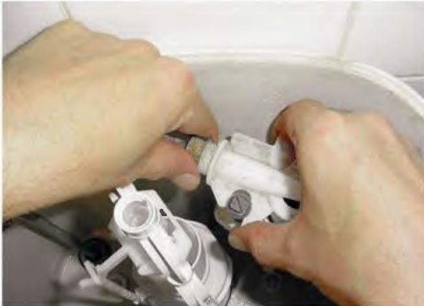
1 - Dévissez le robinet flotteur du réservoir.
