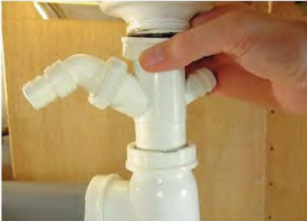
1 - Dévissez le siphon au niveau de la bonde.
