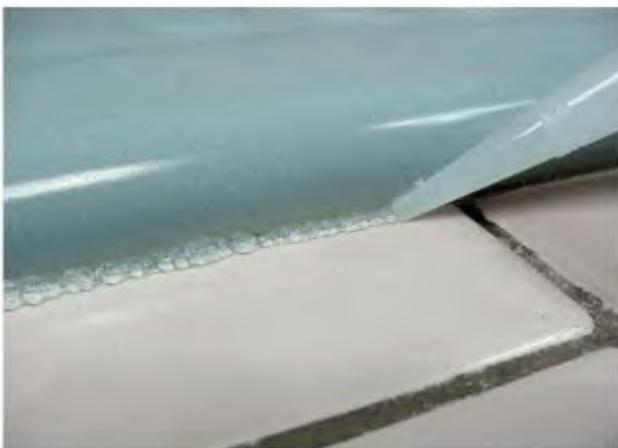
3 - Appliquez un fin filet de mastic.
